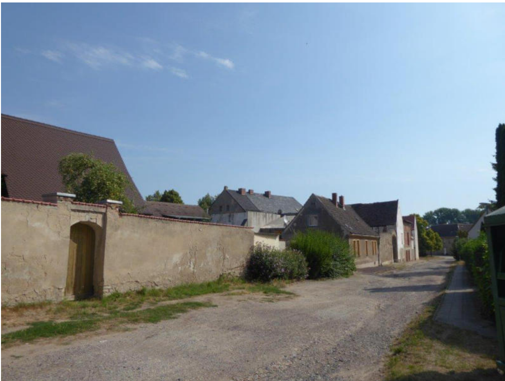
Abbildung 22: Notwendige Straßensanierung am Beispiel (Foto OT Biere)
